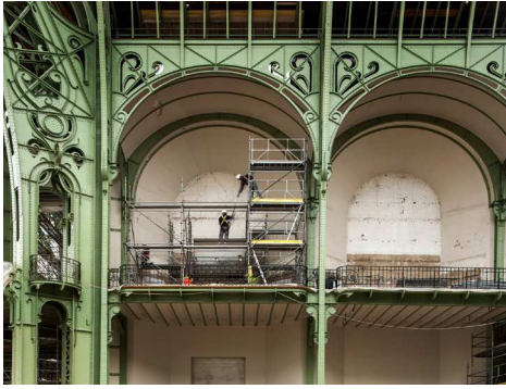
De gauche à droite : La Nef du Grand Palais en travaux, 2023.
